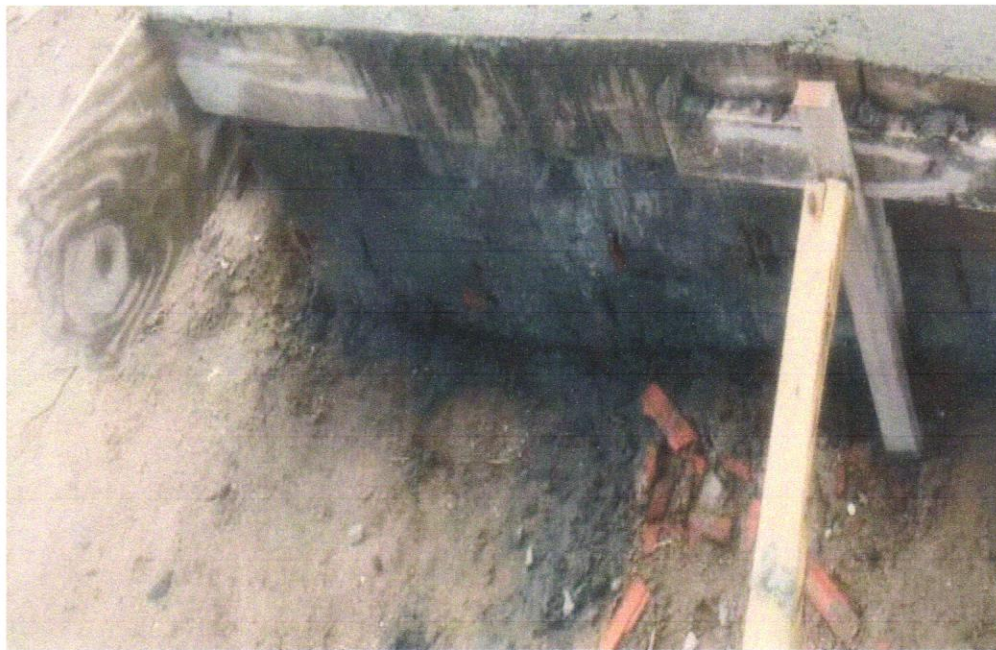
FOTO 01 – CHAPISCO APLICADO EM ALVENARIAS E ESTRUTURAS DE CONCRETO INTERNAS, COM COLHER DE PEDREIRO. ARGAMASSA TRAÇO 1:3 COM PREPARO EM BETONEIRA 400L. AF_06/2014
