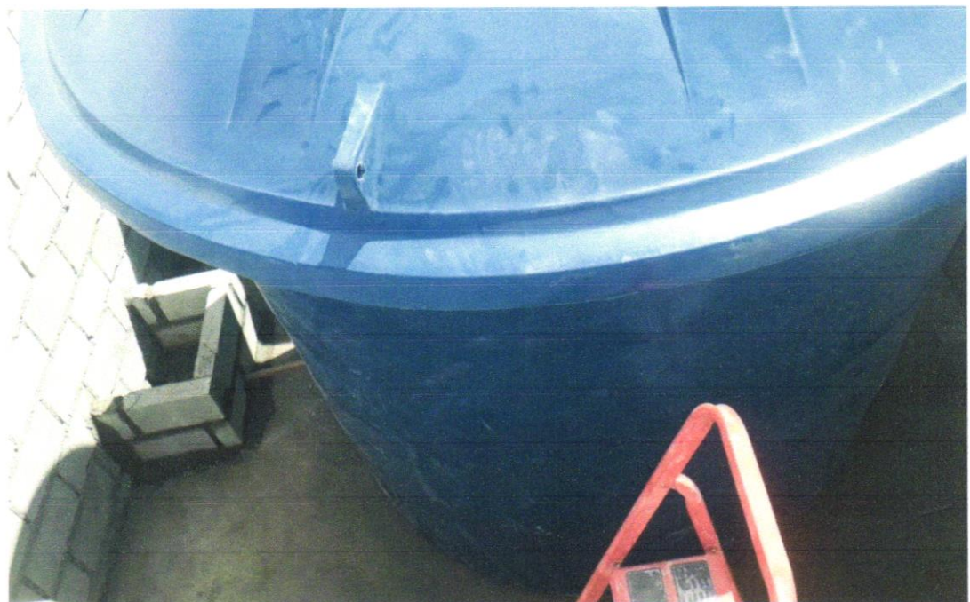
Foto 04 - RESERVATÓRIO DE POLIETILENO 10.000 LITROS
