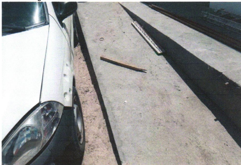
Foto 08 - Rampa padrão para acesso de deficientes a passeio público, em concreto simples f_{ck}=25\text{MPa} , desmoldada, pintada em novacor, 02 demãos e piso tátil de alerta/direcional.
