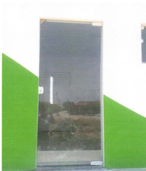
Foto 21 - Porta em vidro temperado 10mm, incolor, inclusive ferragens de fixação e instalação,
