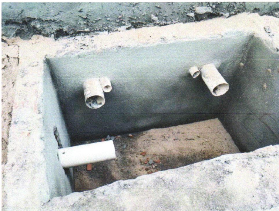
Foto 13 - Sumidouro paredes com blocos cerâmicos 6 furos e dimensões internas de 1,75 x 1,00 x 1,00 m
