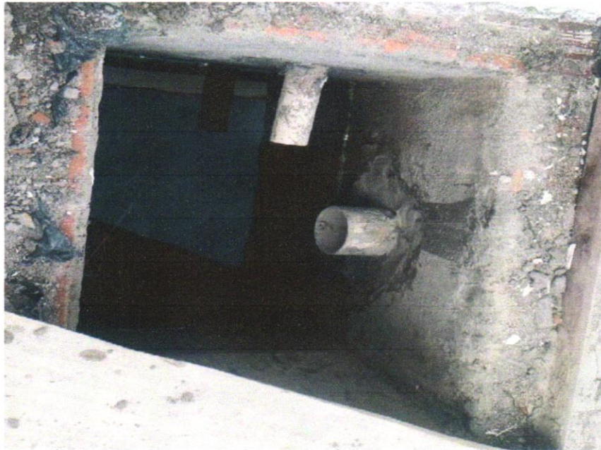
Foto 15 - Caixa de inspeção 0,30 x 0,30 x 0,40m
