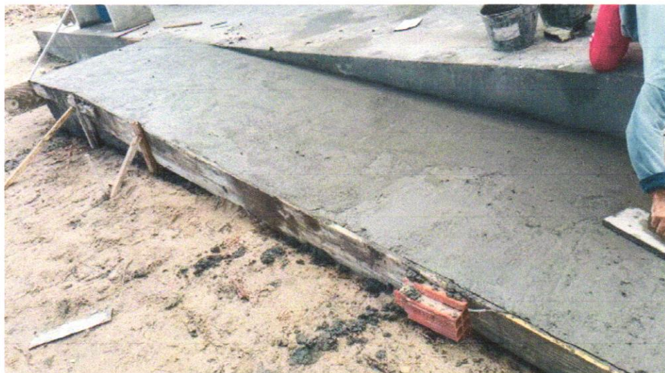
FOTO 02 – Rampa padrão para acesso de deficientes a passeio público, em concreto simples Fck=25MPa, desempolada, pintada em novacor, 02 demãos e piso tátil de alerta/direcional.
